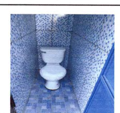
Foto 6: Sustitución de Inodoro y Sustitución de azulejo
