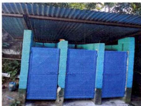
Foto 13: Fabricacion e instalacion de puertas de metal en baños.
