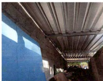
Foto 9: Sustitución de lamina por lamina troquelada aluzinc calibre 26 y Sustitución de estructura de soporte de madera por metal
