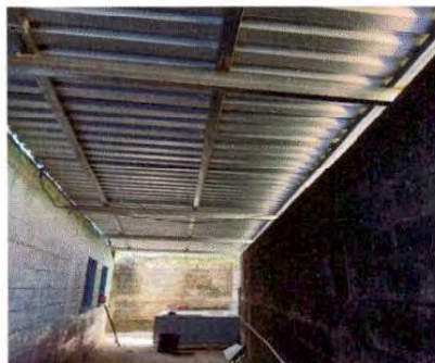
Foto 8: Sustitución de lamina por lamina troquelada aluzinc calibre 26 y Sustitución de estructura de soporte de madera por metal
