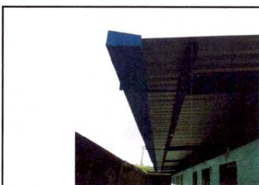
Foto 5: Sustitución de canal de metal
